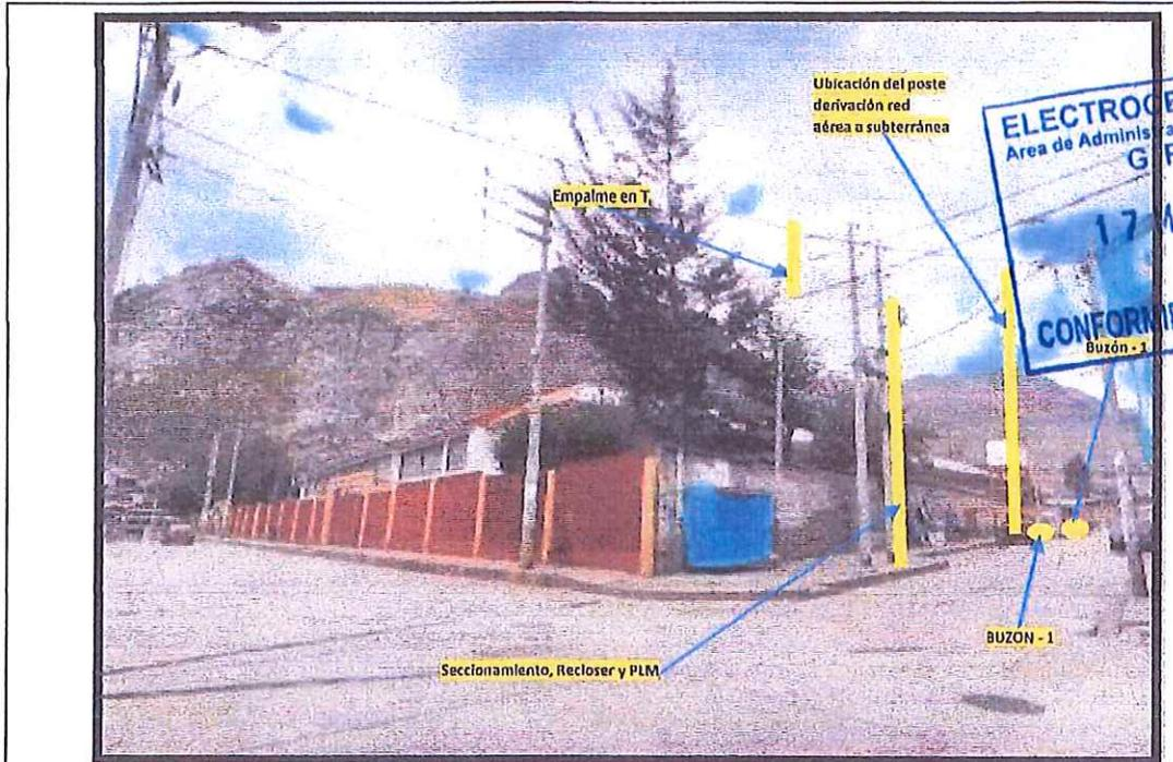
**Vista 01.-** Ubicación del PMI y el empalme en T a la red primaria existente en 10kV y recorrido de línea hasta el poste siguiente donde se realizará la bajada de la red subterránea al buzón 1 y recorrido subterráneo hasta el buzón 2.
